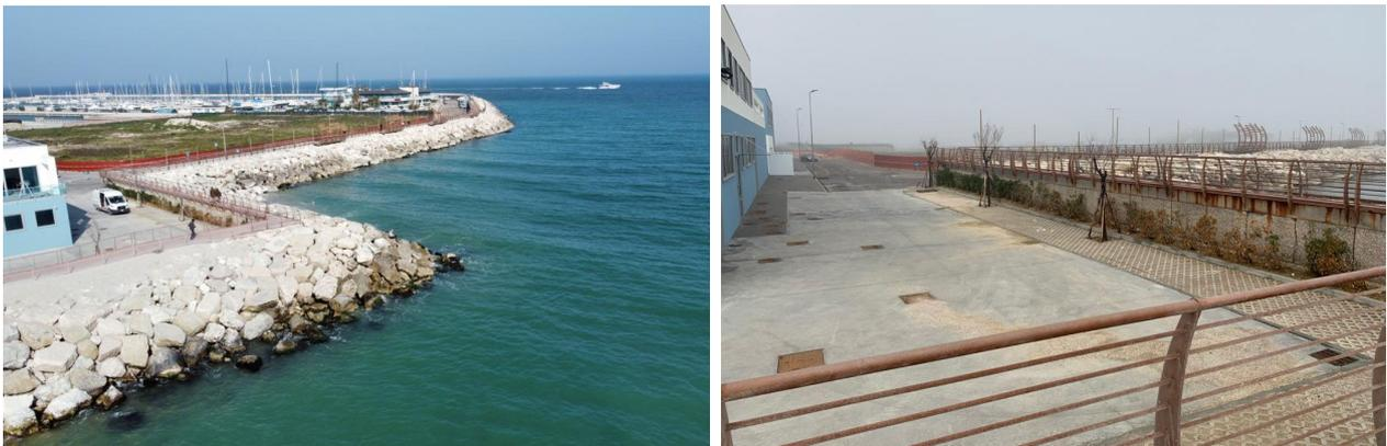
Fig. 3.2/7 Scogliera a protezione dello spigolo del porto (punto di controllo "C")
