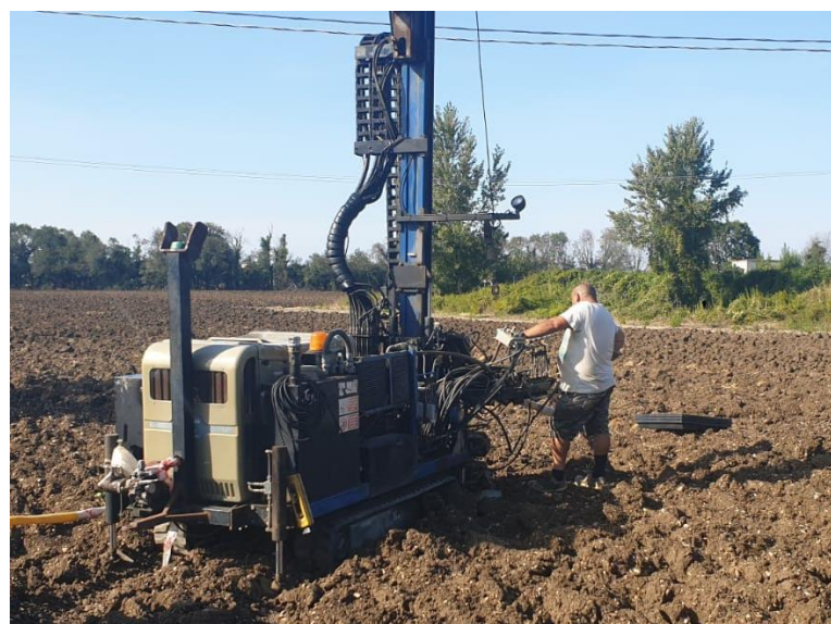
Figura 6.4: mezzo utilizzato per la realizzazione del sondaggio
