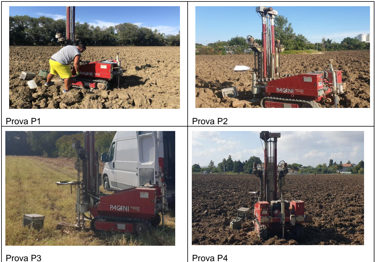
Figura 6.3: foto postazioni delle prove penetrometriche.
