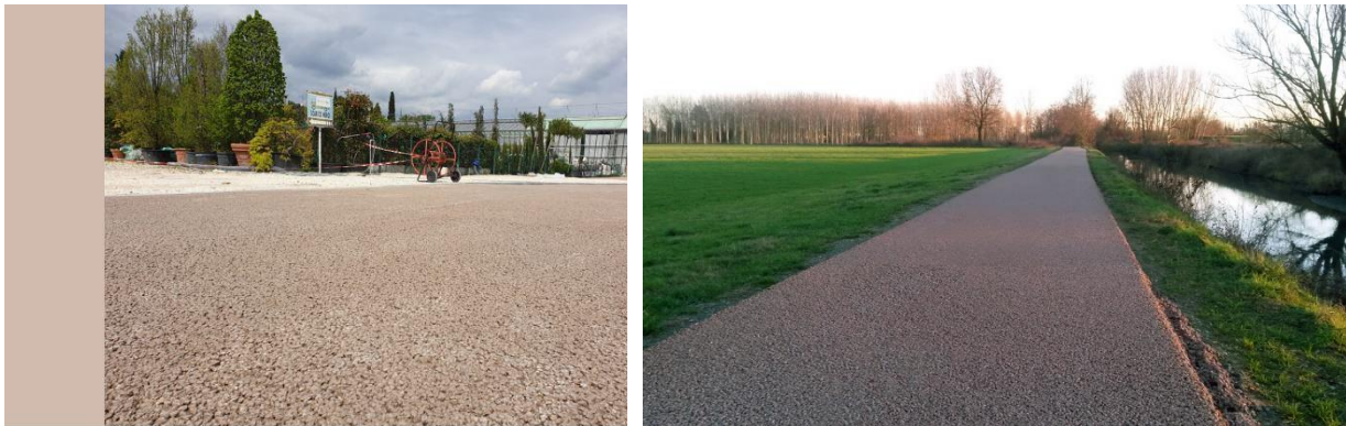
Figura 5 – Calcestruzzo drenante color Tabacco ed esempio di ciclabile in ambito agricolo realizzata in calcestruzzo drenante.
