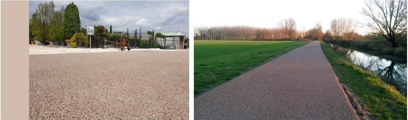
Figura 19 – Calcestruzzo drenante color Tabacco ed esempio di ciclabile in ambito agricolo realizzata in calcestruzzo drenante.
