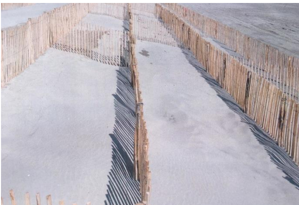
Figura 35 – Esempi di interventi di ricostituzione della duna con barriere frangivento costituite da ganivelles
