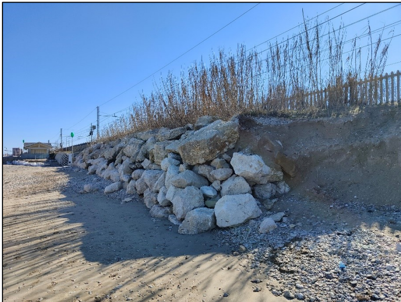
Fotografia 14 - Ripresa fotografica del tratto di spiaggia che comprende il sottopasso del Campeggio Mare Blu fino all'Hotel Playa. Dettaglio della massicciata della ferrovia in erosione.
